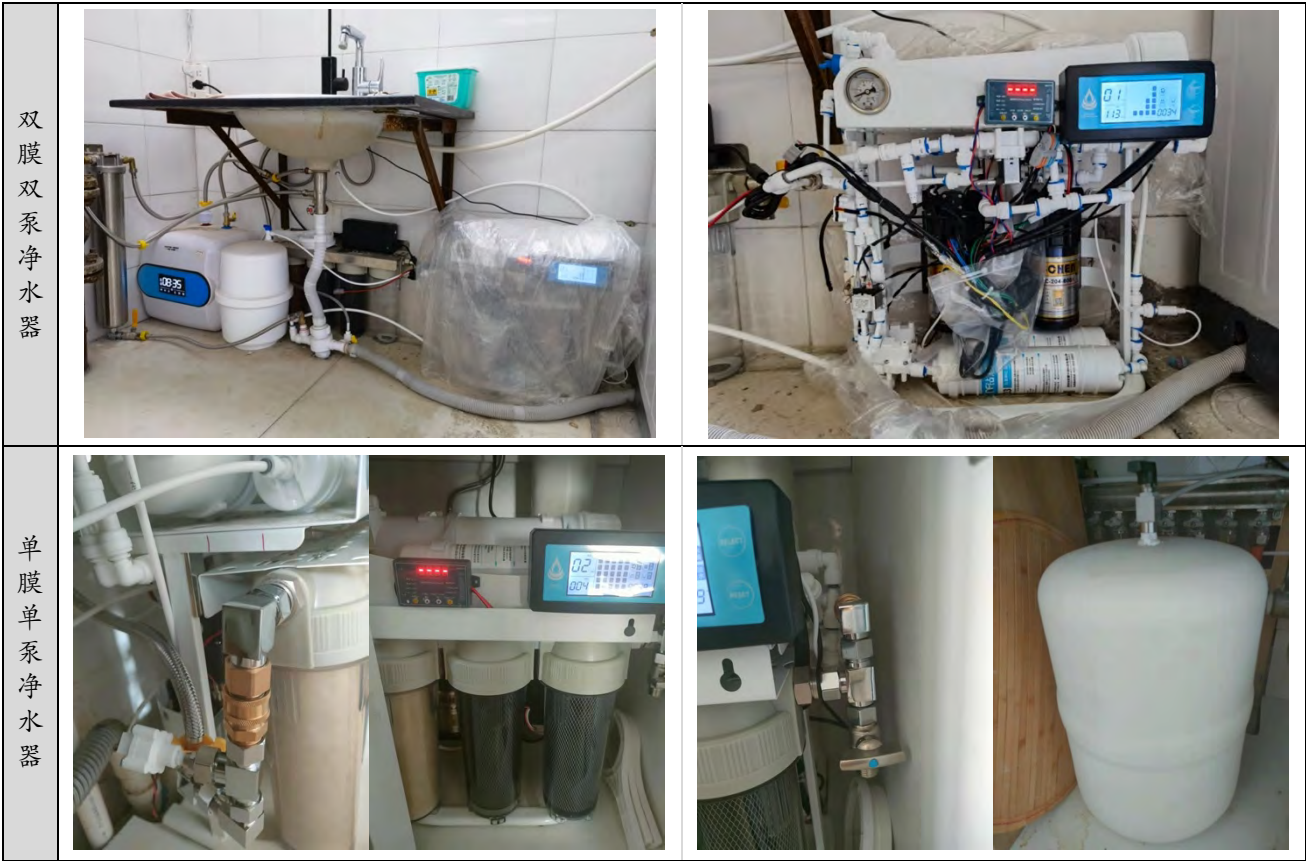
以上是两套不同的范例，上排是双泵双膜净水器、下图是单泵单膜。结构完全一致，用在不同家庭。
